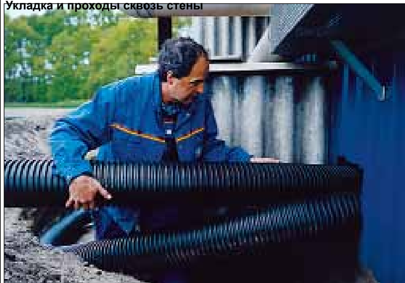
Укладка и проходы сквозь стены
